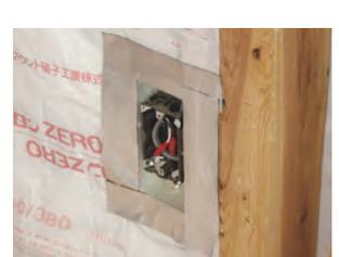
④プラスチック成形品に合わせて防湿ポリエチレンフィルムをカットし、プラスチック成形品のつまとその周りの防湿ポリエチレンフィルムを気密テープで処理し、防湿層を連続させます。
