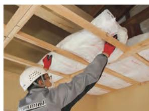
③野縁の上にグラスウールを隙間なく施工します。
