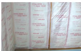
①断熱材を充填し、柱などの見附面に付属防湿ポリエチレンフィルムを留め付けます。
