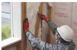
③筋交いの裏に充填し、同面になるように整えます。
