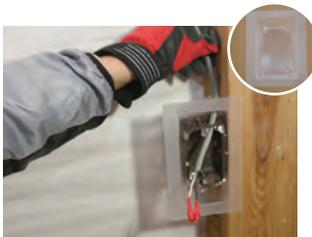
①プラスチック成形品を取り付け、その中にコンセントボックスを施工し配線を通します。プラスチック成形品の配線まわりは気密テープで処理します。
