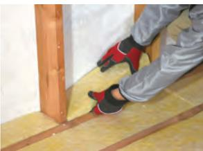
①土台の上部の形状に合わせて加工したグラスウールを施工します。
