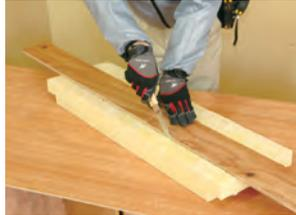
②露断プレミアを加工する場合は、添木を用いて垂直に切断します。
