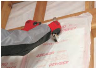
①壁の上部は、胴差または桁の見附面に耳(防湿ポリエチレンフィルム)を30mm以上重ねて留め付けます。
