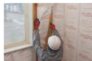
②防湿ポリエチレンフィルムを筋交いの一方に合わせてカッターで切れ目を入れます。切れ目を入れていない一方から防湿ポリエチレンフィルムを取り出します。
