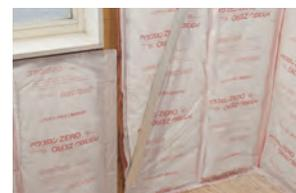
④防湿ポリエチレンフィルムを筋交いにかぶせて、タッカーで柱の見附面と筋交いに留め付け、防湿ポリエチレンフィルムの継ぎ目を気密テープで貼り付け、防湿層を連続させます。
