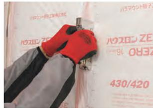
②柱などの間に断熱材を充填し見附面に耳(防湿ポリエチレンフィルム)を留め付けます。
