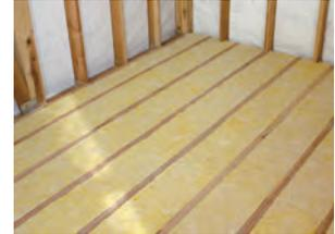
④土台の上や火打ち土台部分など、床面全面に隙間なく露断プレミアを施工します。
