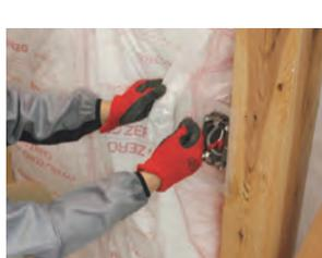
②防湿ポリエチレンフィルムを剥がし、グラスウールをプラスチック成形品の裏側に充填します。
