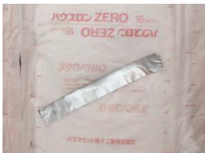
防湿ポリエチレンフィルムに破れなどが生じた場合は、気密テープなどで補修します。
