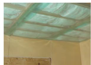
④野縁の下に別張り防湿フィルムを施工します。防湿フィルムは30mm以上重ねます。
