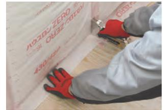
④壁の下部は、床合板の面に耳(防湿ポリエチレンフィルム)を30mm以上重ねて防湿層を留め付けます。
